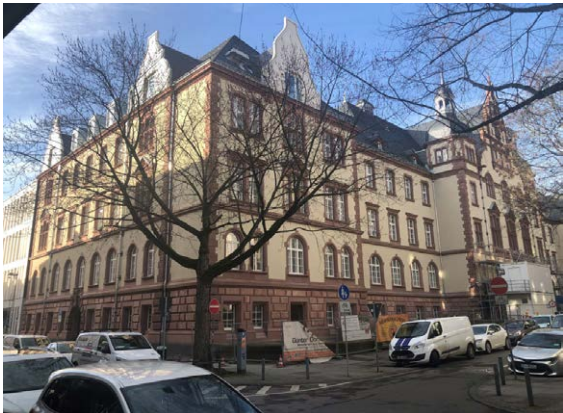
Zustand Februar 2022, geplante Fertigstellung Mitte 2022
