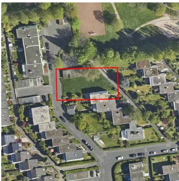
Baulücke am Ortsrand Oben: Baulücken in der Liegenschaftskarte
